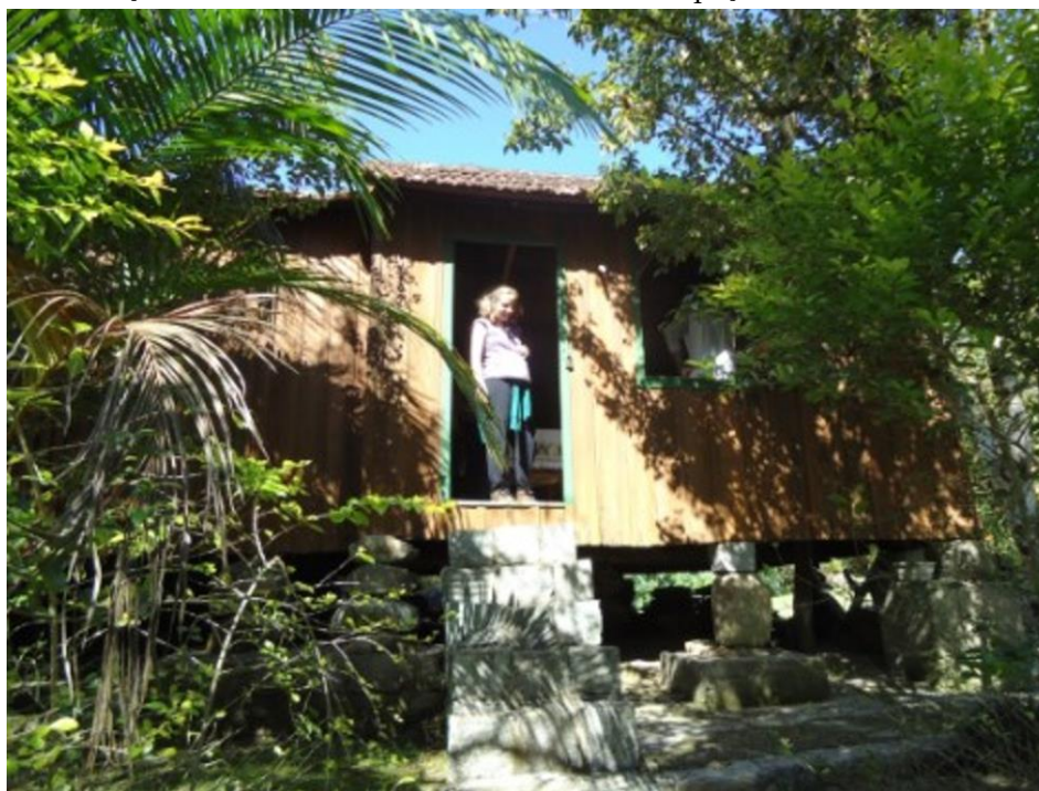
Figura 126 - Fachada posterior da casa evidenciando os alicerces em rochas irregulares elevando a casa com livre circulação de ar entre o assoalho e o terreno, no Espaço Rural Clarear, Camboriú/SC.
