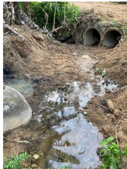
Lançamento de esgoto/ drenagem pluvial/ Rua Paulo Dallago
