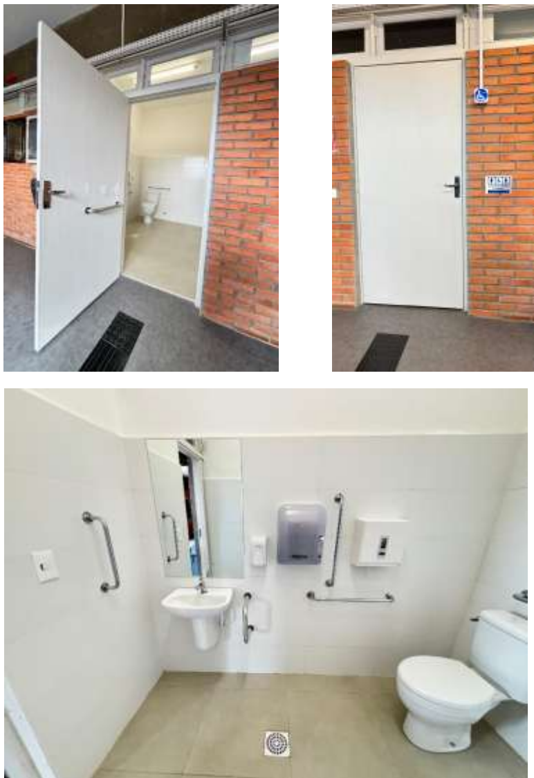
Figura 64: Sanitário PcD unissex -Bloco D1 – campus Profº Edison Villela (Itajaí)
